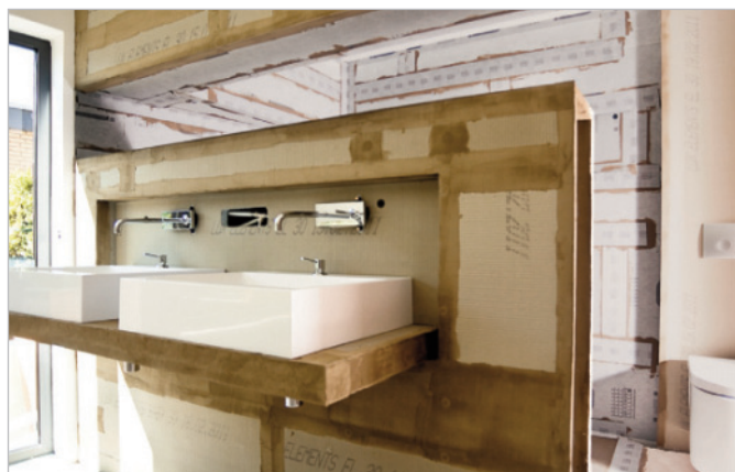
■ Voor de tussenwand worden twee bouwpanelen met verschillend productprofiel ingezet. In het achterste douchebereik werd het in de fabriek afgedichte en dampremmende product LUX ELEMENTS®-ELEMENT-VK ingezet.
