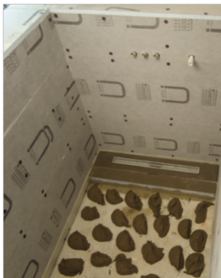
■ In de met de vloer gelijkgewerkte douche met afvoergoot werden vervalelementen verwerkt met de "hoopjestechniek".
