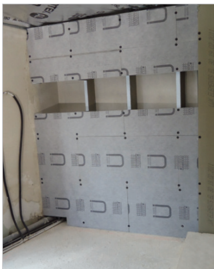
■ In het douchebereik werden in de fabriek afgedichte bouwpanelen aangebracht op een geribde onderconstructie.
