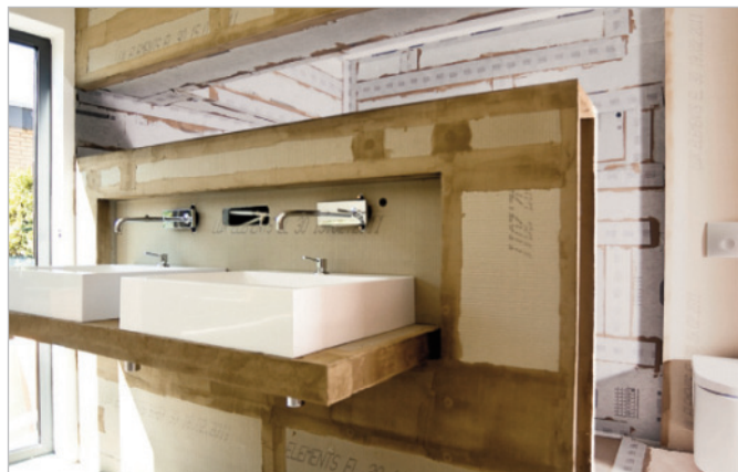
■ Für die Zwischenwand kommen zwei Bauplatten mit unterschiedlichem Anforderungsprofil zum Einsatz. Im hinteren Duschbereich wurde das werkseitig abgedichtete und dampfbremssende Produkt LUX ELEMENTS®-ELEMENT-VK eingesetzt
