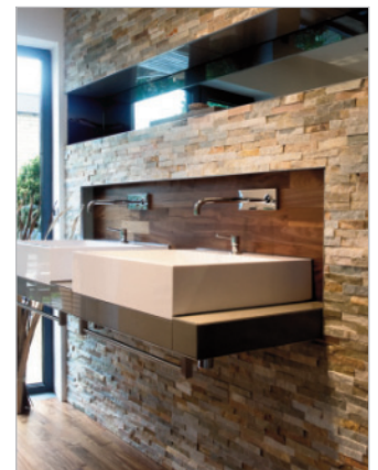
■ Nach der Fertigstellung – Die weißen Design-Waschtische aus edlem Gussmarmor bilden einen schönen Kontrast zum Naturstein Mauerverblender.
