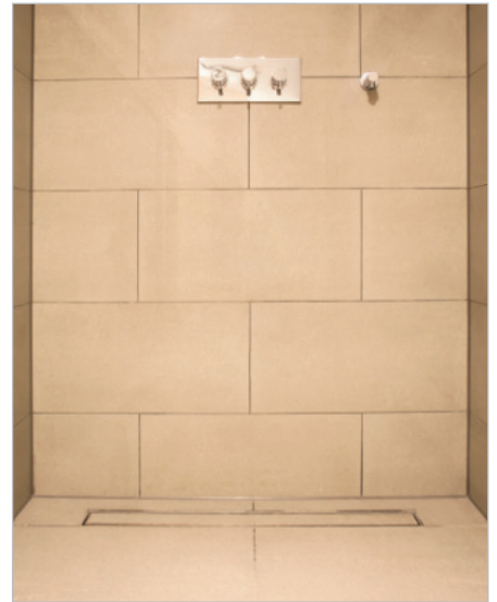
■ Nach der Fertigstellung – Die Dusche wurde mit Feinsteinzeug verfließt, im Bodenbereich kam ein rutschhemmendes Material zum Einsatz.
