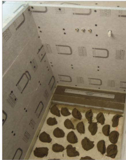
■ In der bodengleichen Dusche mit Ablaufrinne wurden Gefälleelemente mit der „Batzen-technik“ verarbeitet.
