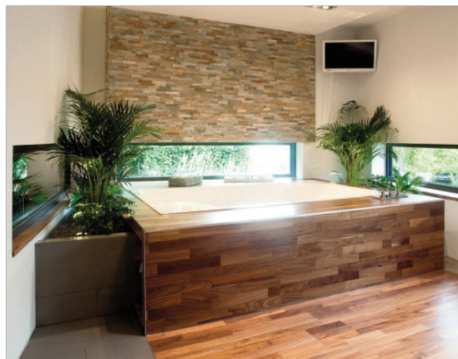
■ Nach der Fertigstellung – Der Wannenbereich ist an drei Seiten durch Wände umhüllt und sehr edel in Echtholzparkett aus Nussbaum gekleidet.
