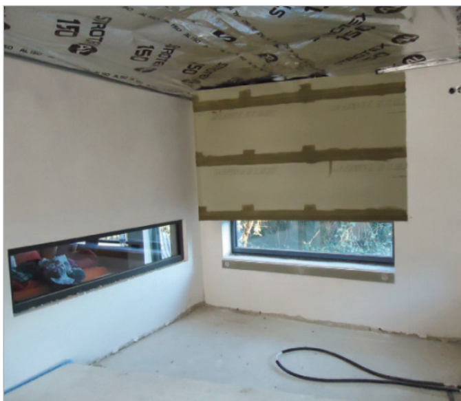
■ Umsetzung – Der insgesamt 18 m 2 große Raum wurde komplett neu aufgebaut, die langen rechteckigen Fenster neu eingebaut.
